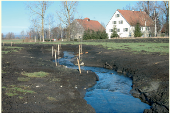
Bei zwei Mühlen wurde die Durchgängigkeit der Schwarzach durch den Bau von Umgehungsgewässern wieder hergestellt.
