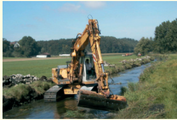
Entfernen der Rasengittersteine.
