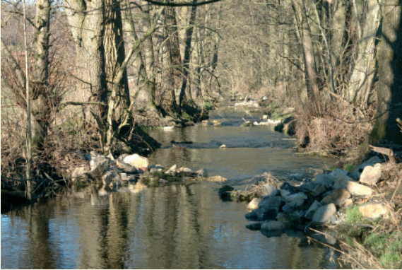
Die Steine des ehemaligen Sohlpflasters tragen als Bühnen und Störsteine zur Strukturvielfalt im Gewässer bei.
