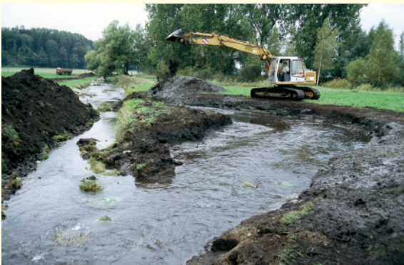
Anlage eines neuen, naturnahen Gewässerbetts.
